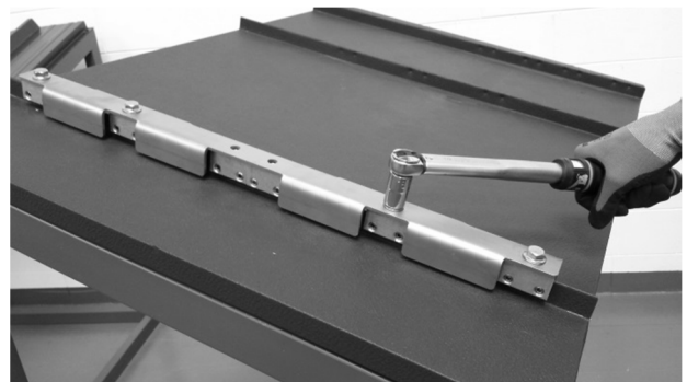
6 – SERRAGGIO BULLONI M10 (9 X 20 Nm)
